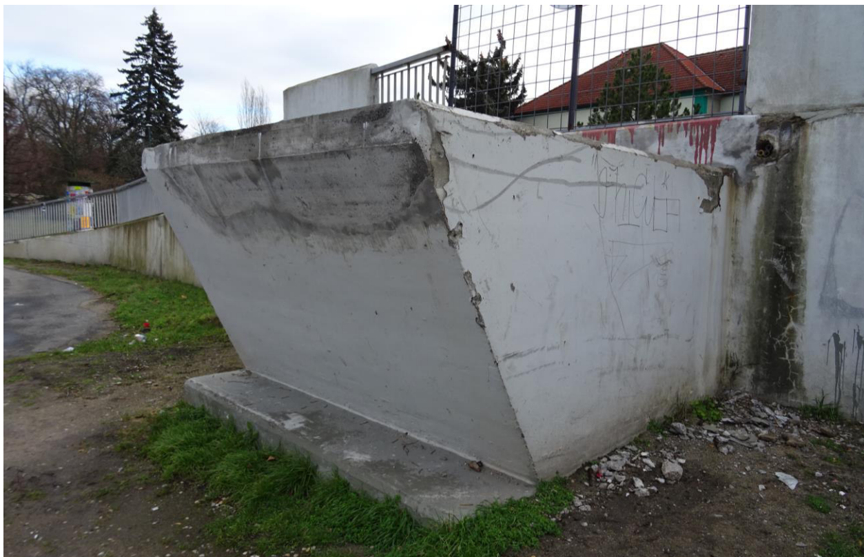
Obr. 1 Opěra 01 – pohled na sedlo
